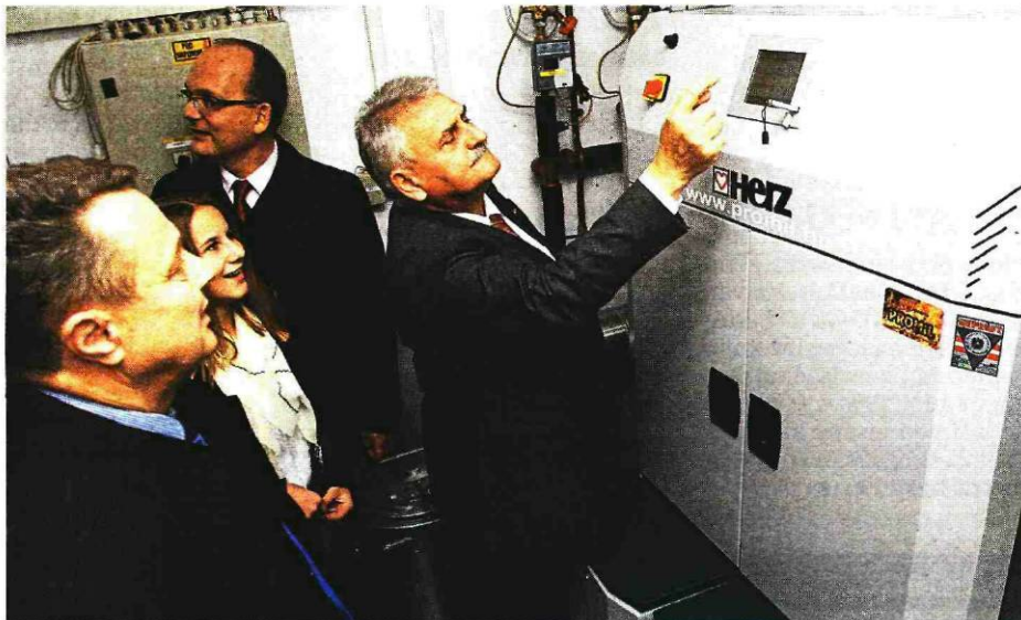
Novi kotao na biomasu, odnosno pelete, donijet će znatne uštede u grijanju K. ŠTEDUL FABAC/PIXSELL
